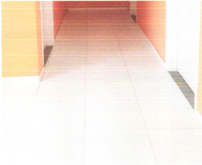
FOTO 07 - REVESTIMENTO CERÂMICO PARA PISO COM PLACAS TIPO ESMALTADA EXTRA DE DIMENSÕES 45X45 CM APLICADA EM AMBIENTES DE ÁREA MAIOR QUE 10 M2. AF_06/2014
