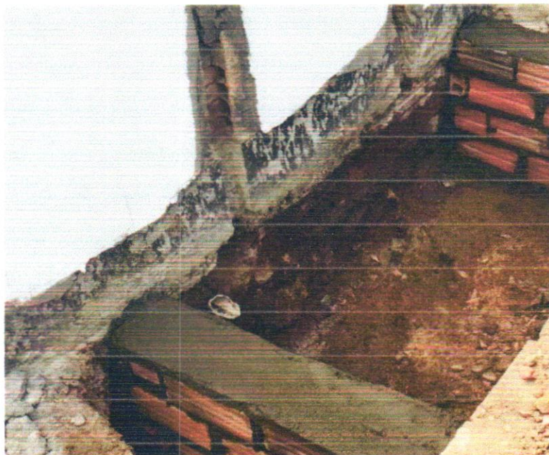
FOTO 13 - Sumidouro paredes com blocos cerâmicos 6 furos e dimensões internas de 1,00 x 1,00 x 0,60 m
