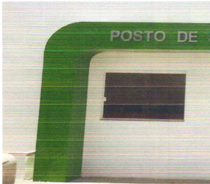
FOTO 03 - Revestimento metálico em alumínio composto (Alucobond), e=0,3mm, pintura Kaynar 500 composta por seis camadas, inclusive estrutura metálica auxiliar em perfil de viga "U" de 2" - fornecimento e montagem
